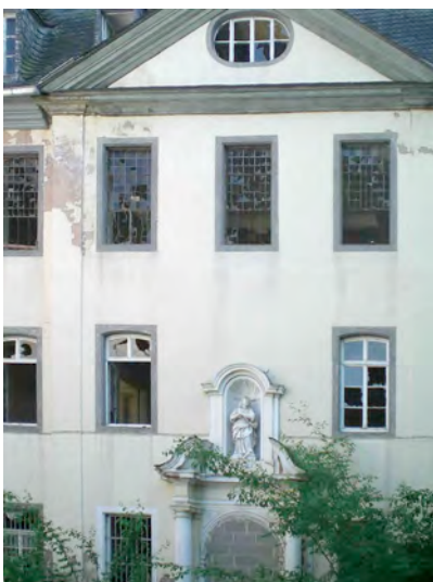
Bild 2: Zertrümmert und zugemauert – das stadtbildprägende Kloster Marienberg in Boppard, das direkt an der Bahntrasse liegt!
