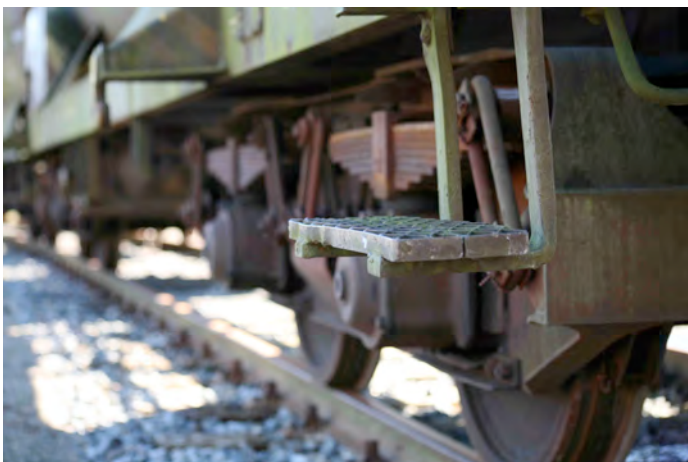
Bild: Gefahren durch alte Trassen und alte Güterzüge.
