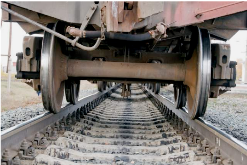
Bild 1: Starre Achsen und Fehler an den Laufflächen der Räder und der Schienen sind neben zu hohen Geschwindigkeiten, zu langen Zügen, zu hohem Gewicht und veralteter Bremsstechnik und Federung einige der Ursachen für abnormen Bahnlärm. Die Vorschriften für eine technische Überwachung fehlen ebenso wie Grenzwerte für Lärmemissionen von Fahrzeugen und Schienen.
