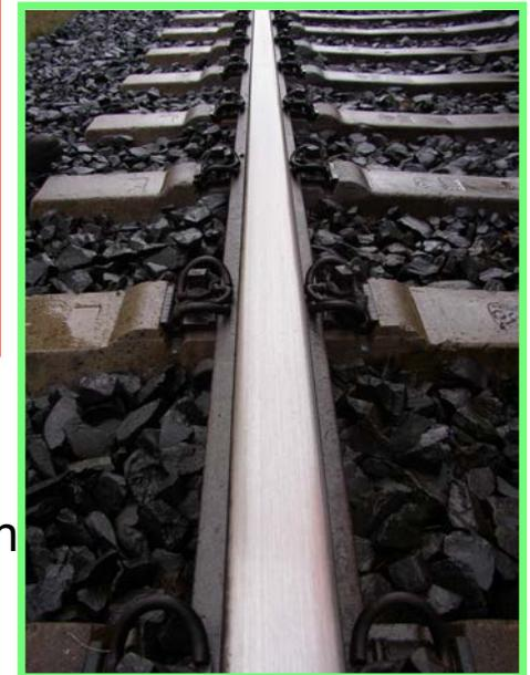
nach dem oszillierenden Schleifen
